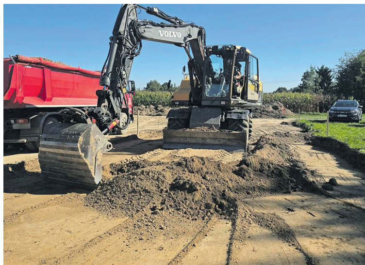
Roboty już się rozpoczęły
