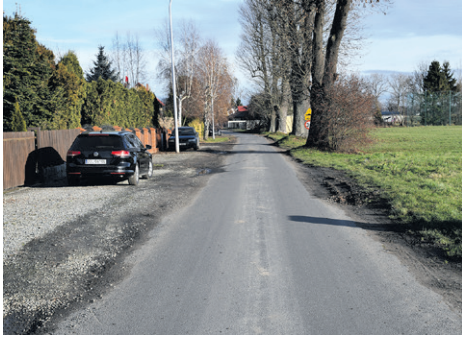
Przebudowa drogi gminnej w Świerzej
