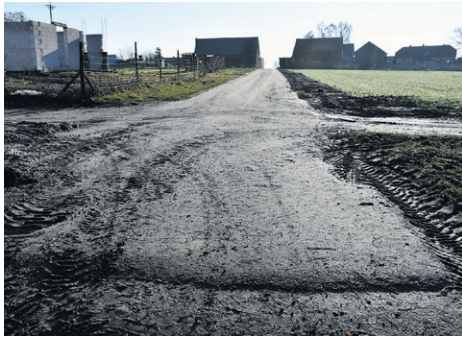
Przebudowa drogi wewnętrznej w Zarzysku
