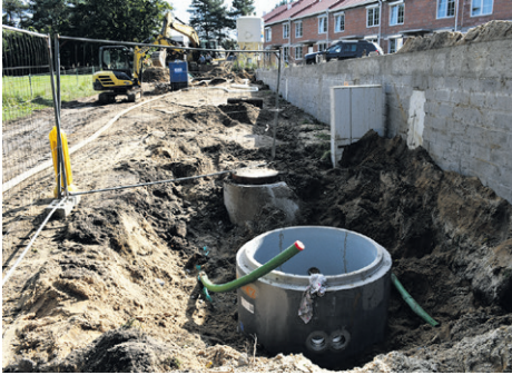
Budowa sieci kanalizacji sanitarnej w Jenkowicach, Sokołowicach - Gęsiej Górcie
