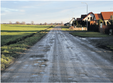
Przebudowa drogi wewnętrznej - ul. Mokrej w Bystrem (kontynuacja)
