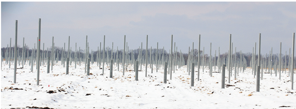
Po horyzont ciągnie się las ocynkowanych, równo osadzonych w glebie słupów
