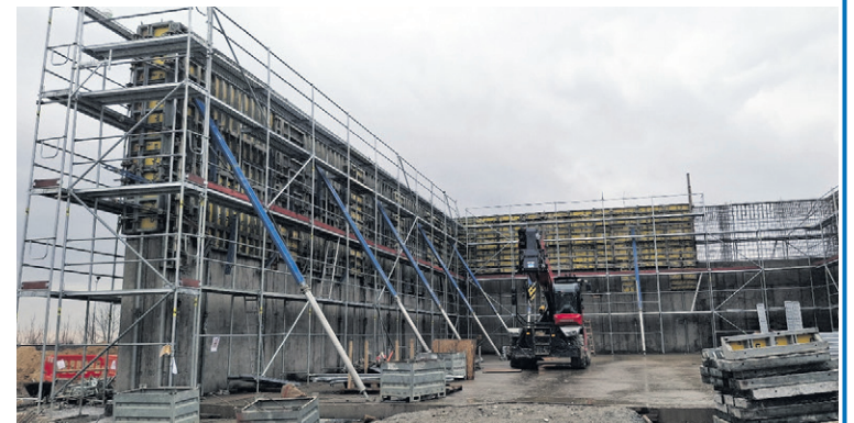
Deskowanie ścian magazynu 7-dniowego w części górnej
