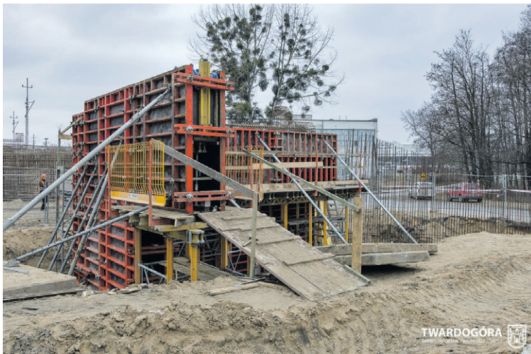
Buduje się nowy wiadukt
