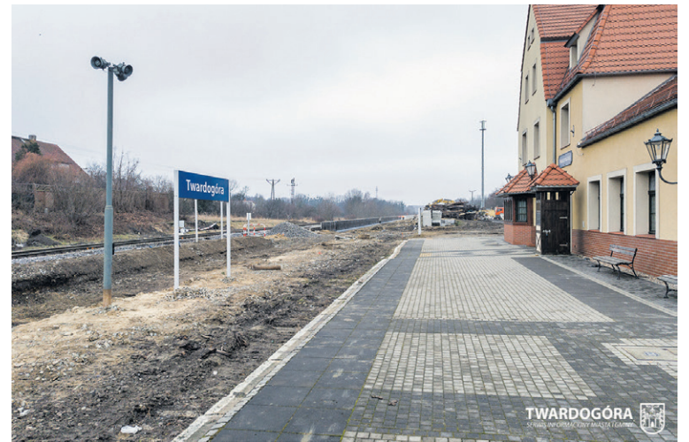
Trwa przebudowa dworca
