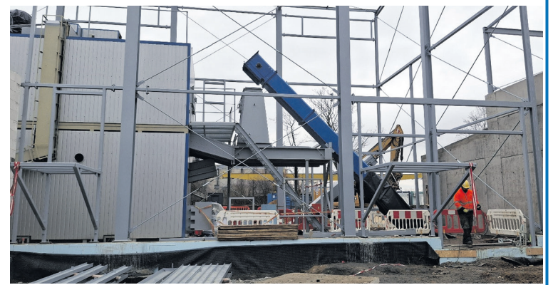
Konstrukcja stalowa budynku hali kotła
