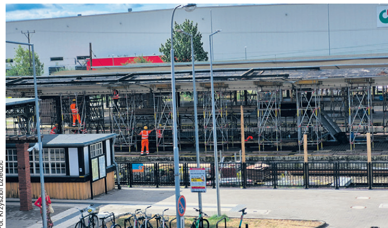
Remontowany jest peron nr 1
