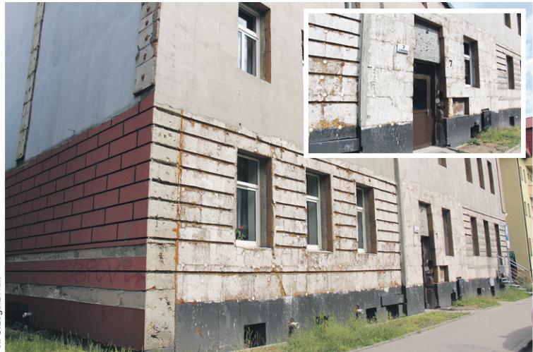
Remont tu stanął. I tak już zostanie?
