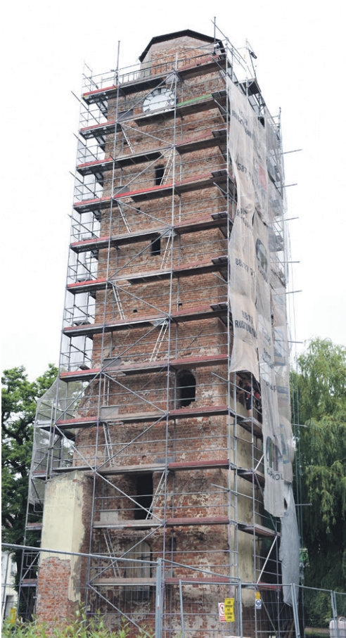
W trakcie prac
