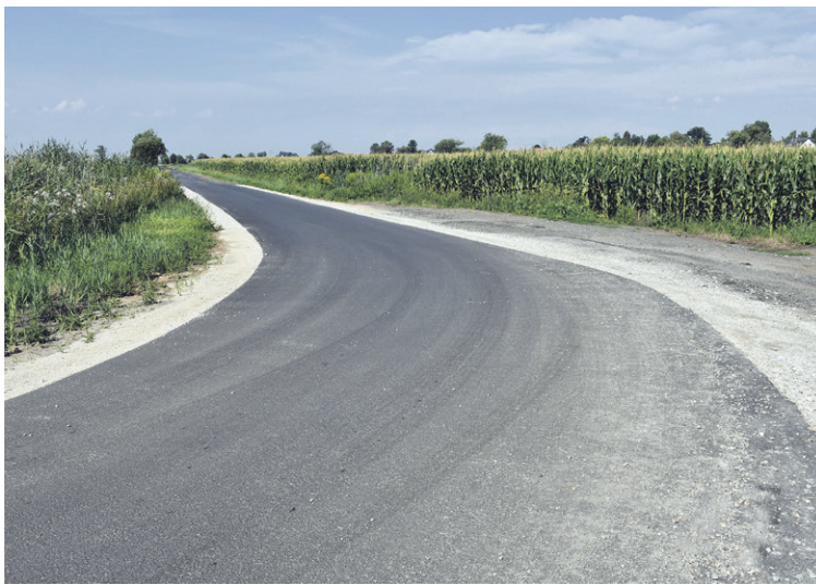
I etap remontu ulicy Turkusowej wykonano w roku ubiegłym
