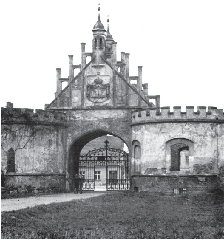
Brama z wypalonymi pomieszczeniami - początek lat 50 XX w.
