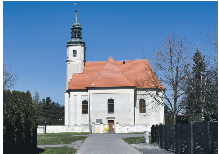
W kościele w Cieślach kapitalnemu remontowi poddano dach
