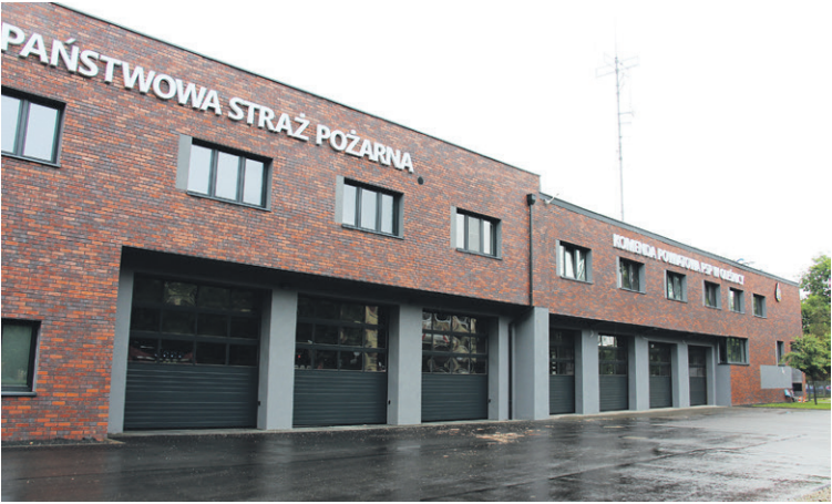
Tak wygląda po rozbudowie
