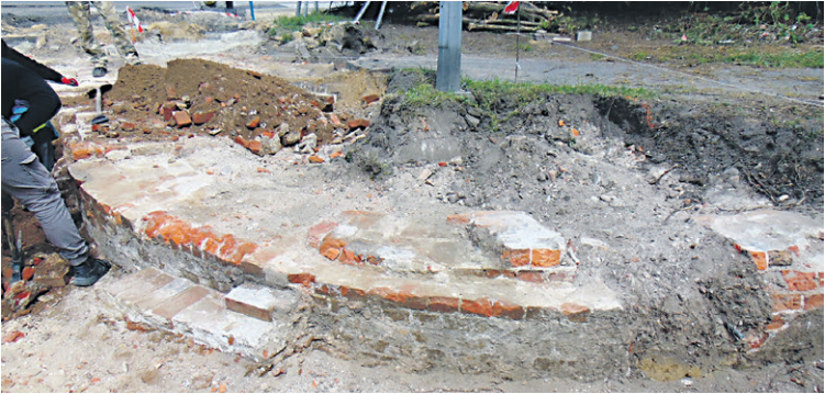
Fundamenty lewej strony bramy zamkowej
