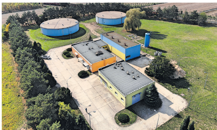
ZUW przy Dobroszyckiej przeszedł niedawno modernizację zbiorników za 1 mln
