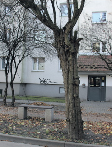
Uschnięte drzewo stanowi zagrożenie
