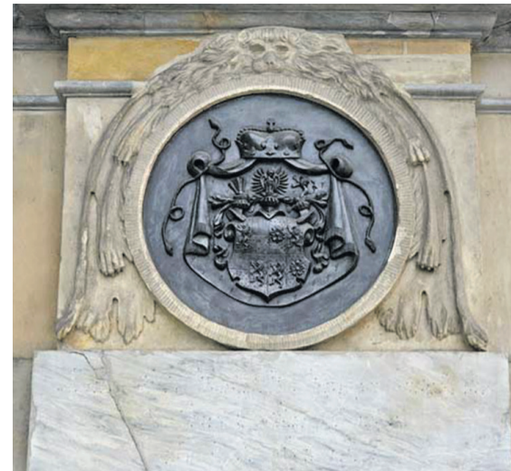
Próba wyjęcia medalionu może się skończyć katastrofą. Już teraz widać popękane elementy nad i pod medalionem
