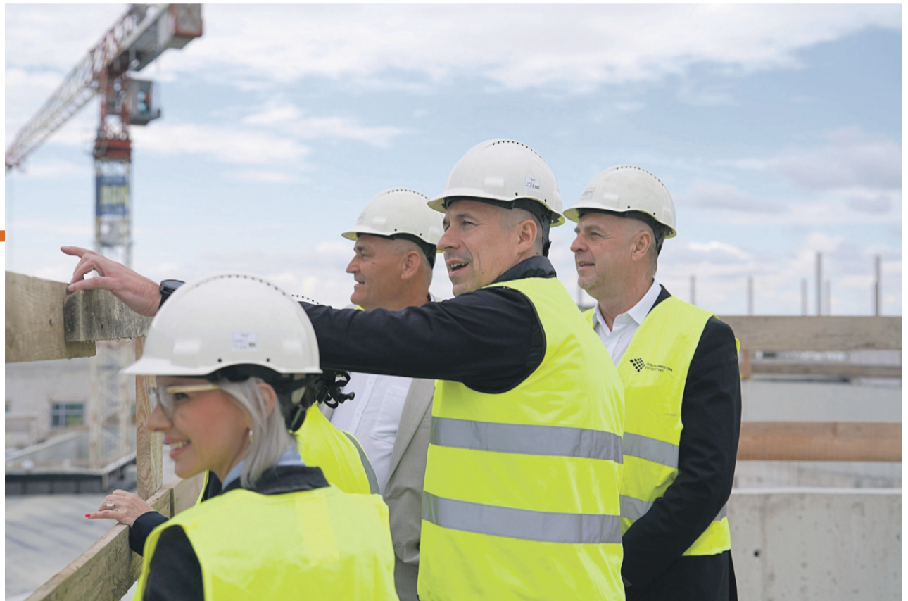
Marszałek Paweł Gancarz podkreśla, że Nowy Szpital Onkologiczny to największa inwestycja w zdrowie Dolnoślązaków. Tempo prac na budowie jest bardzo dynamiczne.
