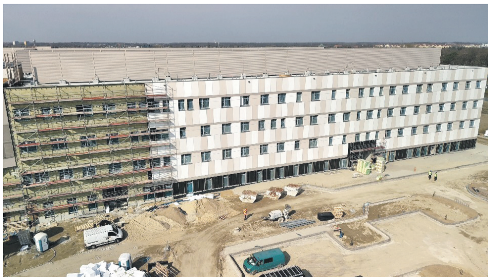
Budynki szpitala z zewnątrz będą ukończone już za chwilę
