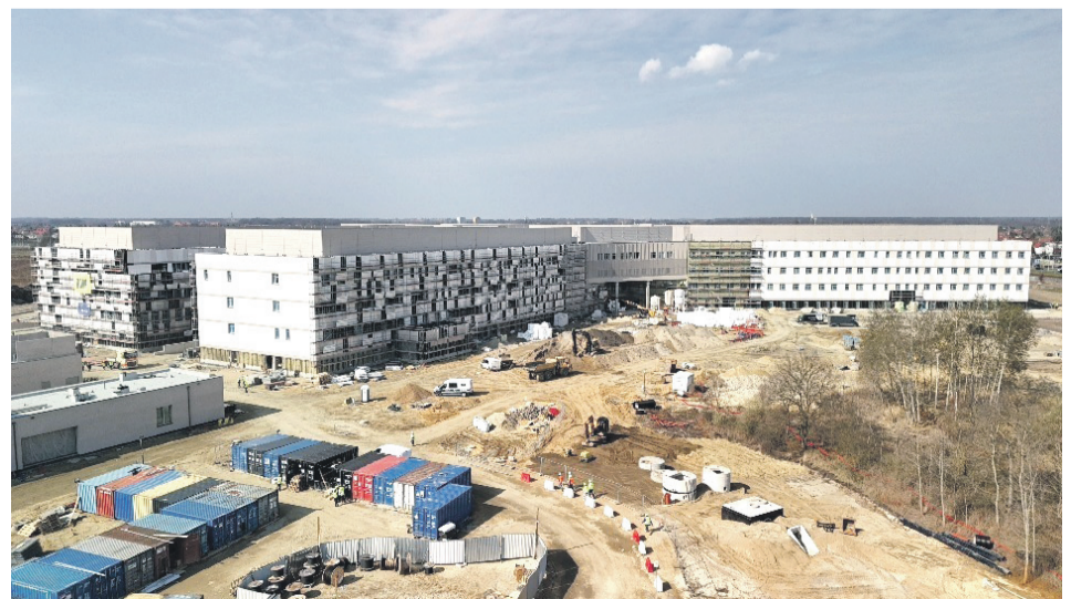
Budowa Nowego Szpitala Onkologicznego idzie pełną parą
