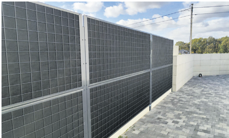
Konstrukcje będą wysokie na ponad 6 m
