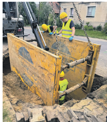
Robi się kanalizacja
