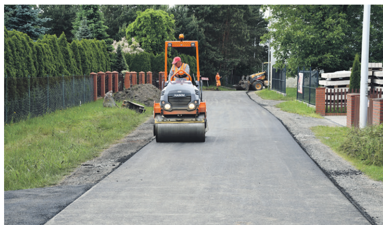
Prace remontowe w Sokołowicach już trwają
