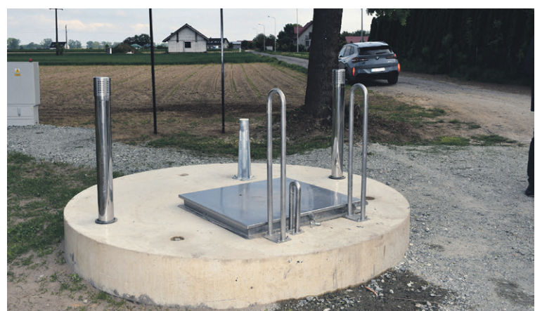
Zakończył się I etap budowy kanalizacji w Jenkovicach
