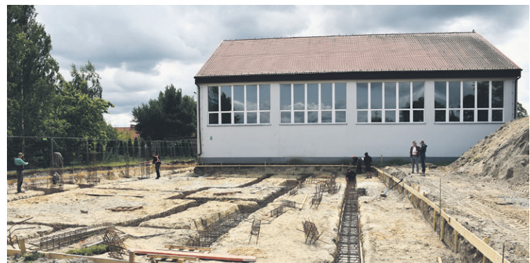
Wkrótce po podpisaniu umowy ruszyły prace ziemne
