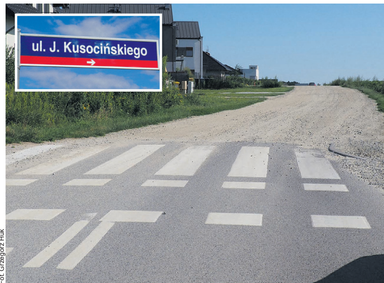
Asfalt zostanie pociągnięty dalej w stronę osiedla
