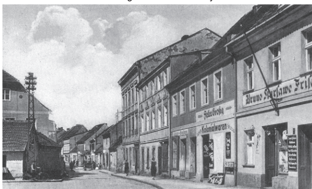
Od prawej trzy budynki wypalone w 1945 roku. Zostały wyburzone
