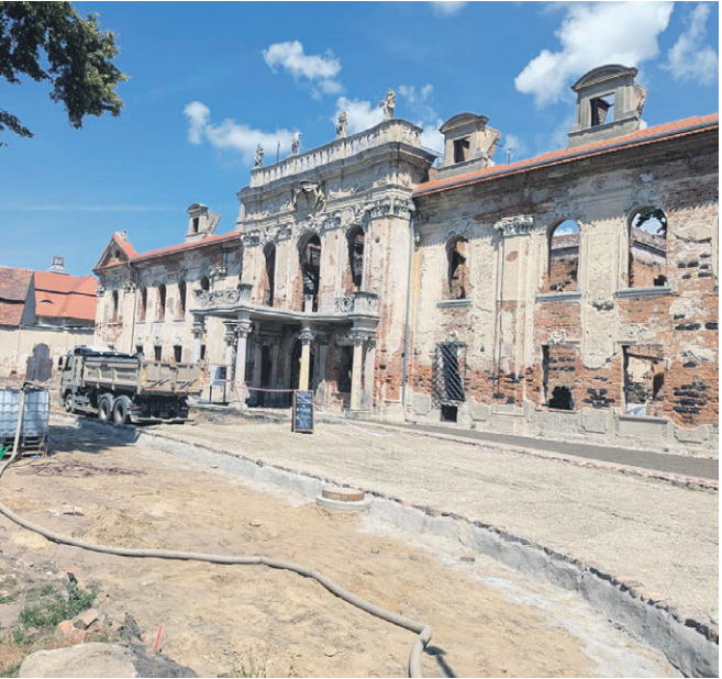
Dziedziniec stał się placem budowy
