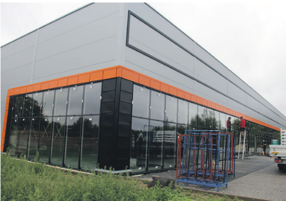
Szklana fasada gotowa
