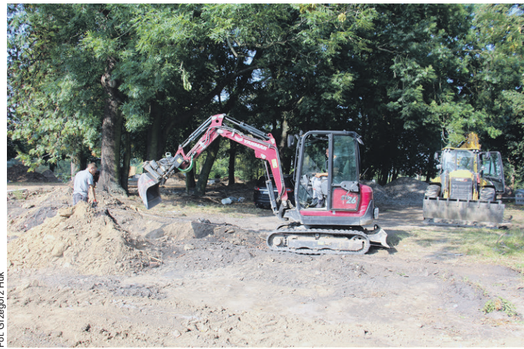
Trwają tu prace ziemne
