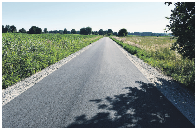
Ulica Turkusowa w Smardzowie po przebudowie
