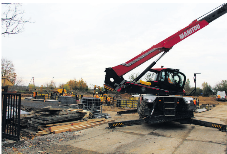
Fundamenty już widać
