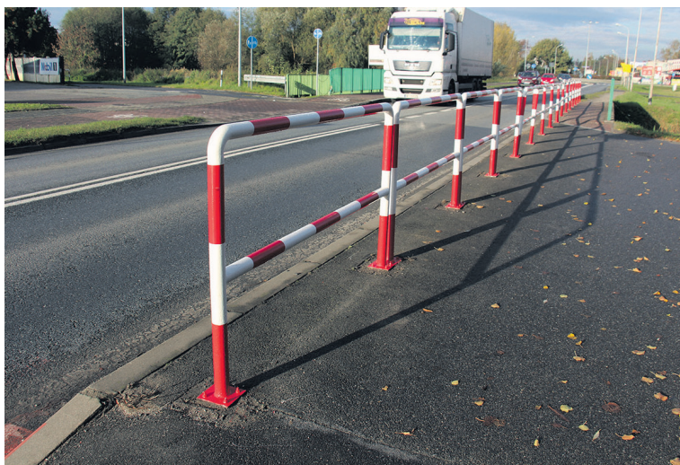
Prace już trwają
