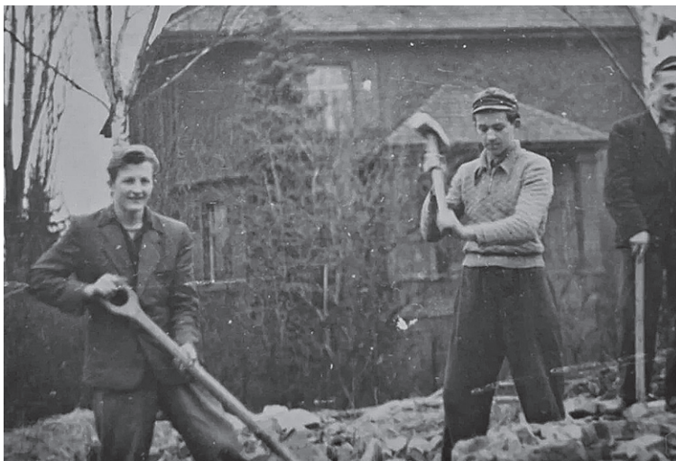
Porządkowanie otoczenia budynku, 1952 rok
