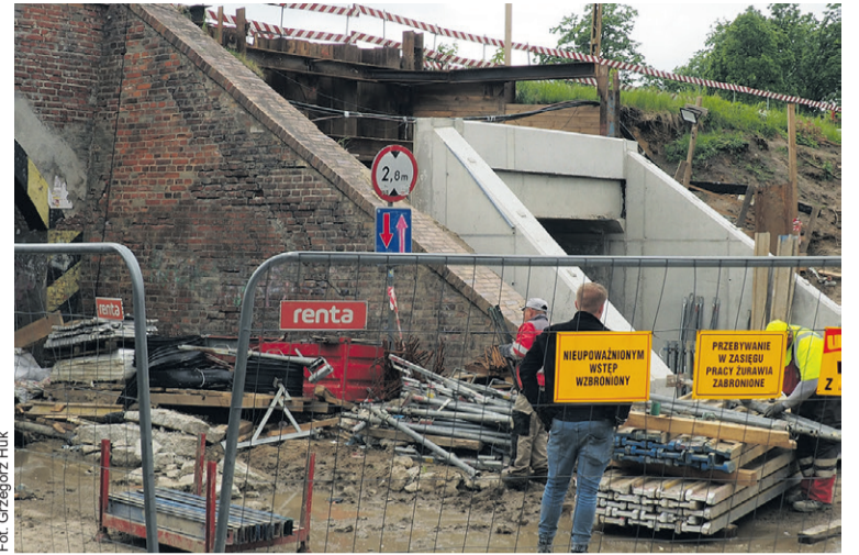
Przebudowa powoduje różne utrudnienia
