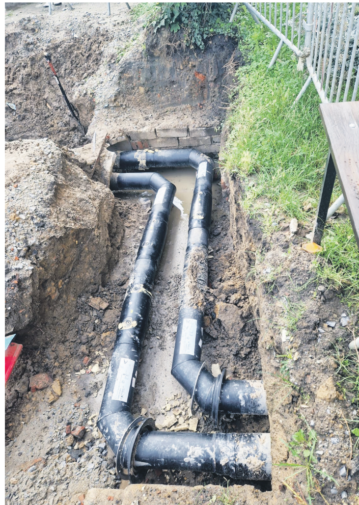
Wymiana sieci tradycyjnej na preizolowaną
