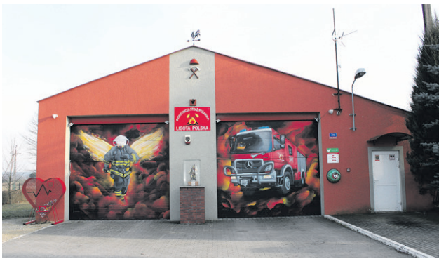
Modernizacja energetyczna budynku remizy w Ligocie Polskiej
