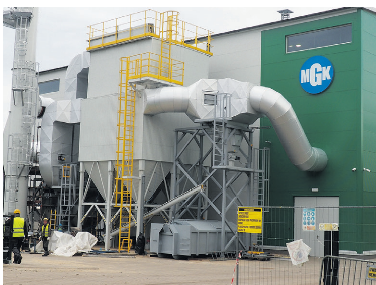
Instalacja jest już gotowa
