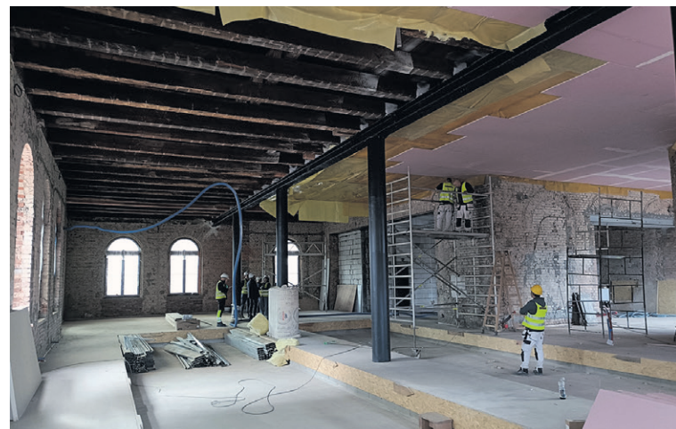
Wnętrze dworca w trakcie remontu
