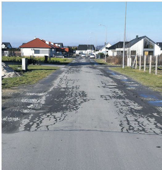
Prace w Dąbrowie trwają
