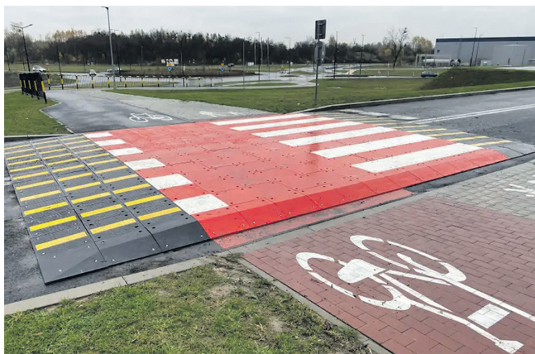
Taki płytowy próg zostanie zamontowany na łączniku
