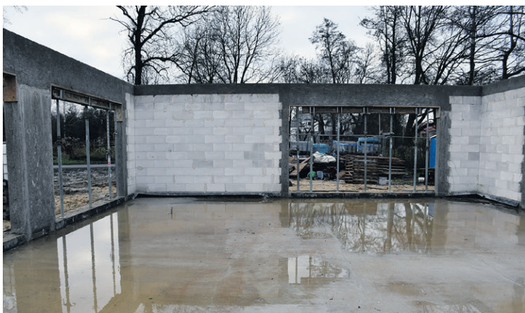
Trwa budowa świetlicy w Spalicach
