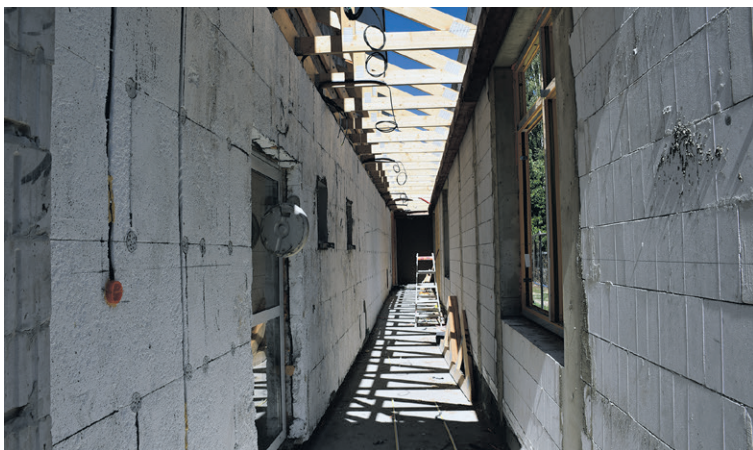
Prace przy rozbudowie SP w Smolnej
