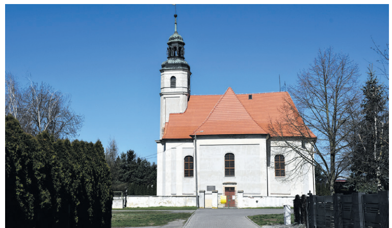
Cieśle - remont dachu
