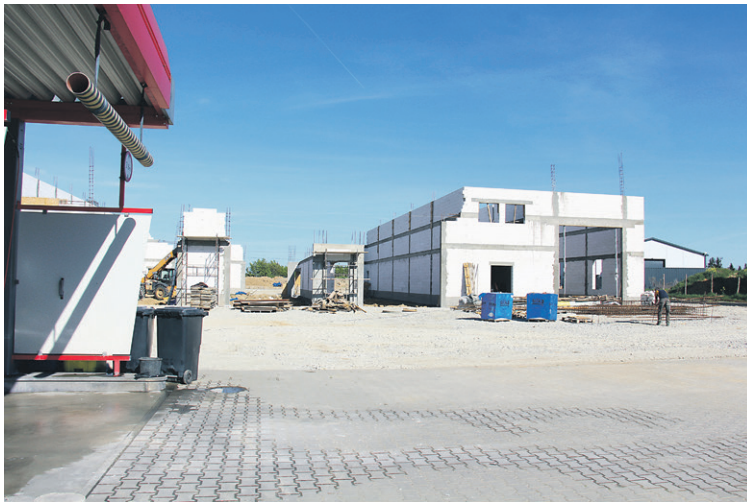
Trwa rozbudowa myjni przy Dobroszyckiej
