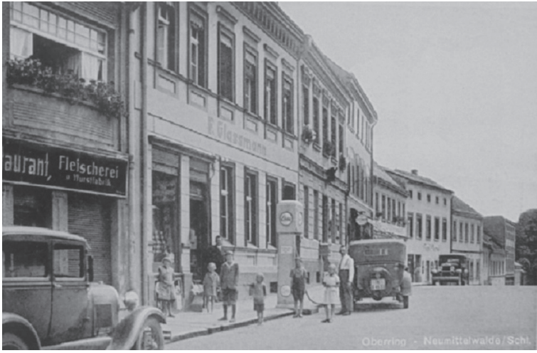
Dystrybutor pod oknami - dziś niemożliwe
