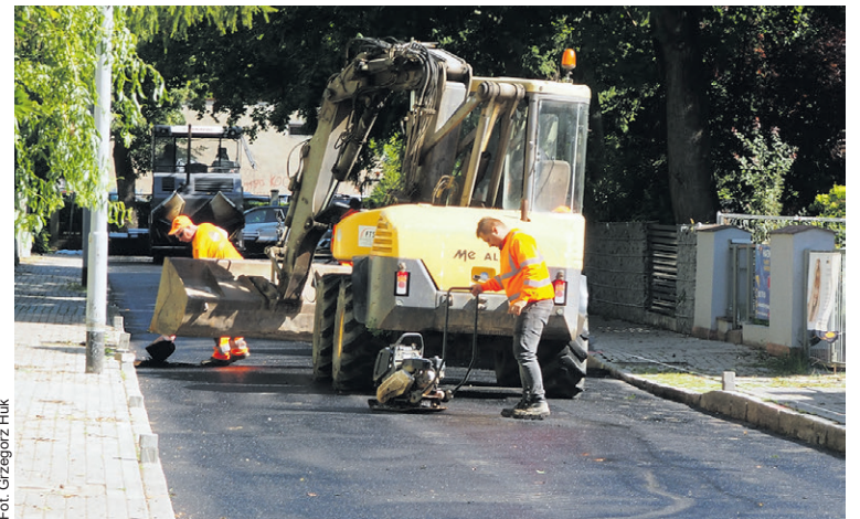
Będzie nowa nawierzchnia ulicy Bocka
