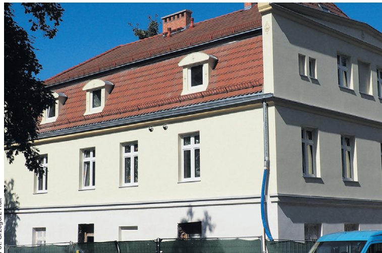
Kamienica już po remoncie
