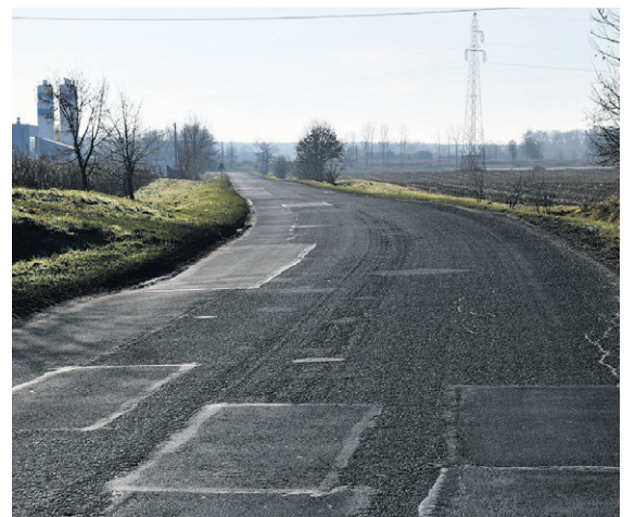
Droga w Smardzowie zostanie przebudowana
