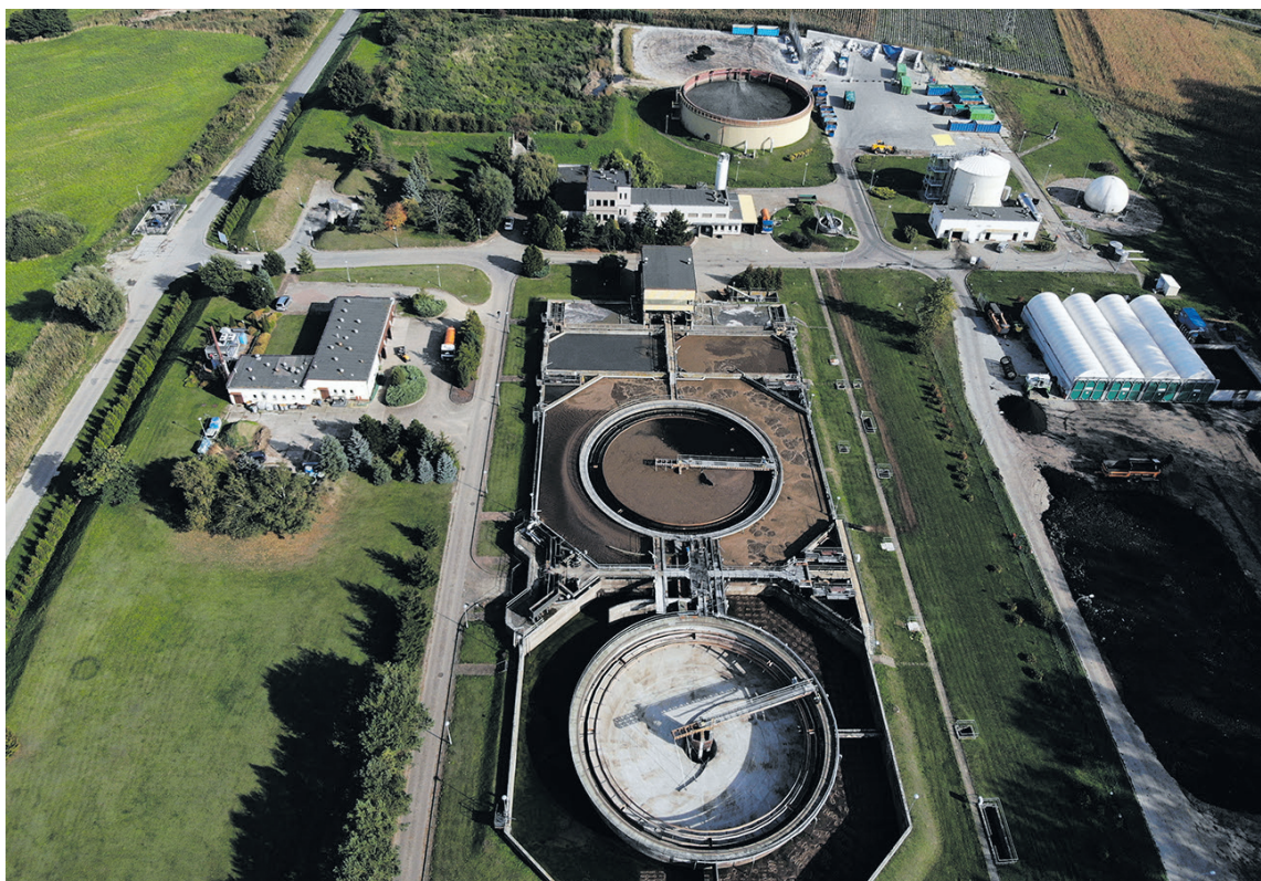
Oczyszczalnia ścieków - widok ogólny
