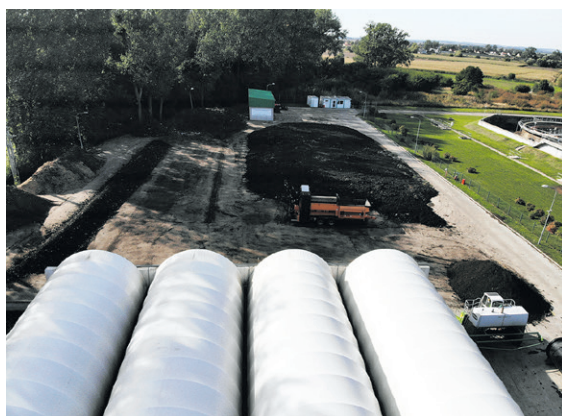
Koprownia odpadów zielonych i osadów ściekowych
