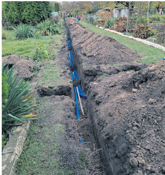
Prace postępują szybko
